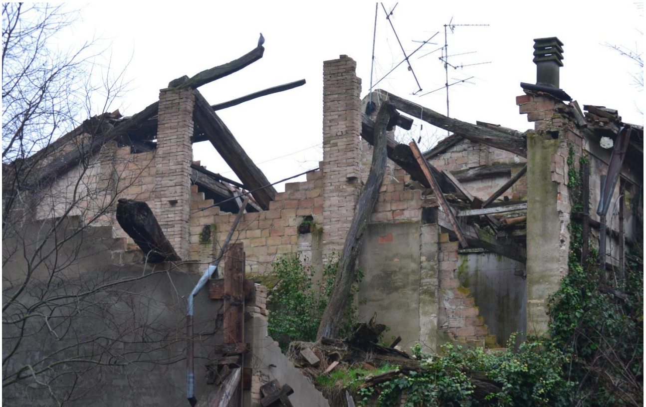
Figura 11– Crollo completo della stalla con fienile allo stato attuale (febbraio 2024)
