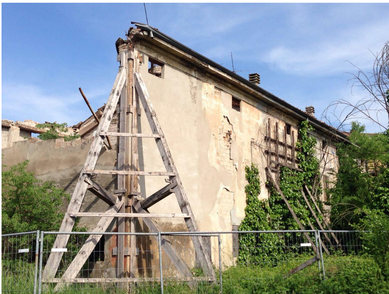
Figura 10 – Posa del puntello sul muro della stalla (maggio 2016)
