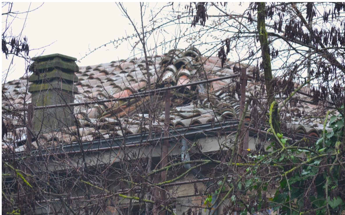
Figura 9 – Squarcio della copertura visibile sul lato sud della parte residenziale dell'edificio (febbraio 2024)
